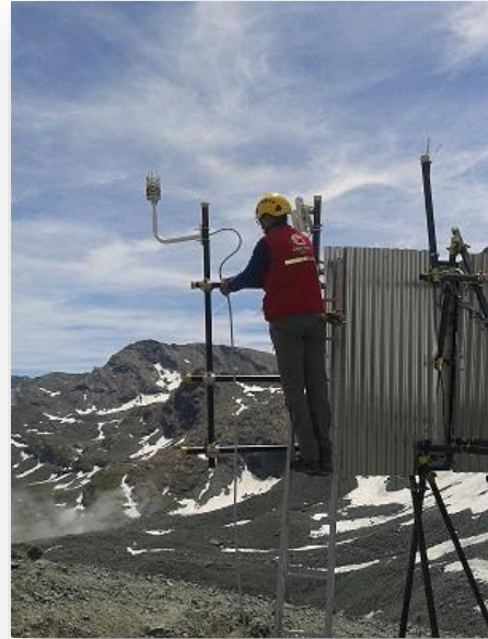
L'installazione delle apparecchiature
